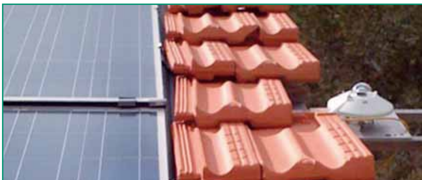
3. ábra. Pyranométer lehetséges elhelyezése
