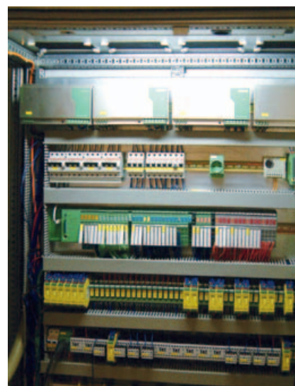
2. ábra. Vezérlőszekrények PROFINET I/O vezérlővel: ILC 350 PN a Phoenix Contacttól. Ez látja el az egyidejű PROFINET- és INTERBUS-rendszerű kommunikációt
