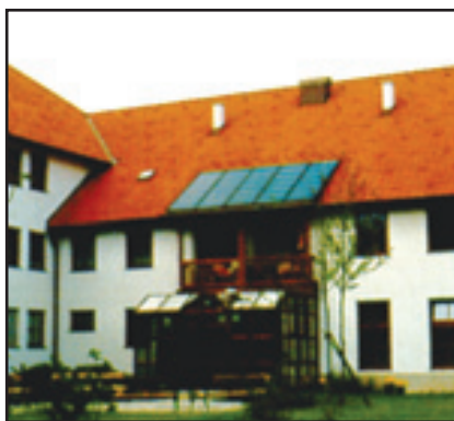
2. ábra. Napelemmodulok a háztetőn
